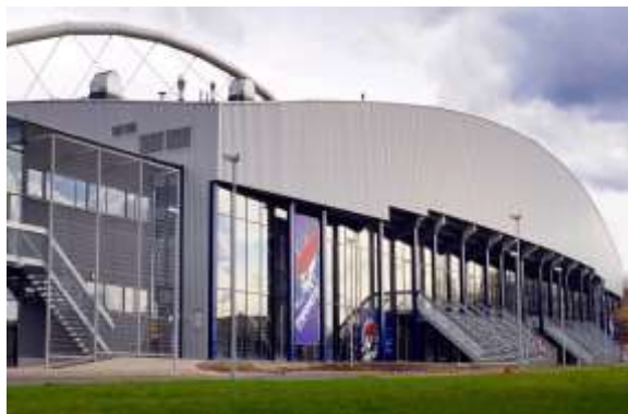
Obrázek 3 Zimní stadion – exteriér, Chomutov
