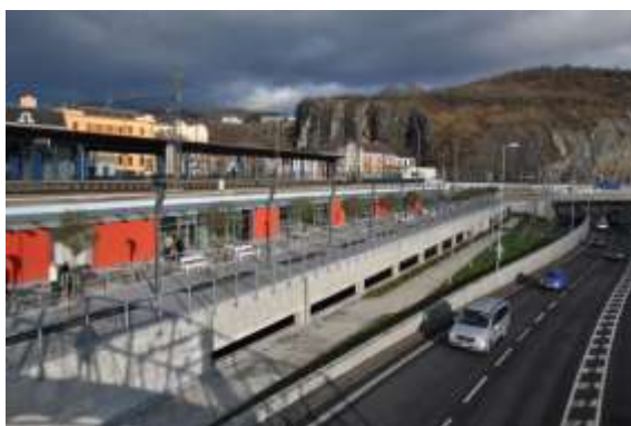
Obrázek 1 Pohled na objekt zánadraží a Přístavní ulici
